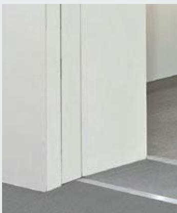
Nischenklappe bei geöffnetem Tor
