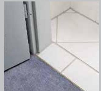
Das Türblatt kann im unteren Bereich gekürzt werden. Mit diesem Höhenausgleich bis 20 mm passt die Tür bei jeder Modernisierung.
