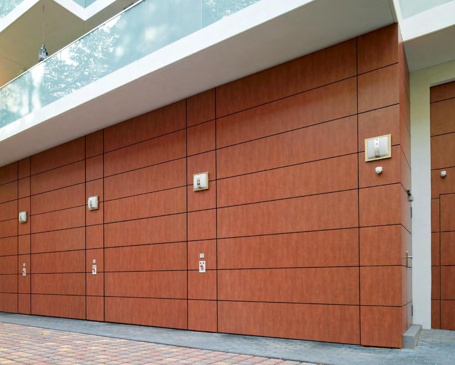
OBEN RECHTS. ALR F42 mit bauseitiger, flächenbündiger Beplankung aus Schichtpressplatten
