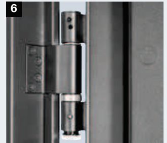
Einfacher Austausch der Bandrollen am Türblatt (Abbildung Multifunktionsstür OD)
